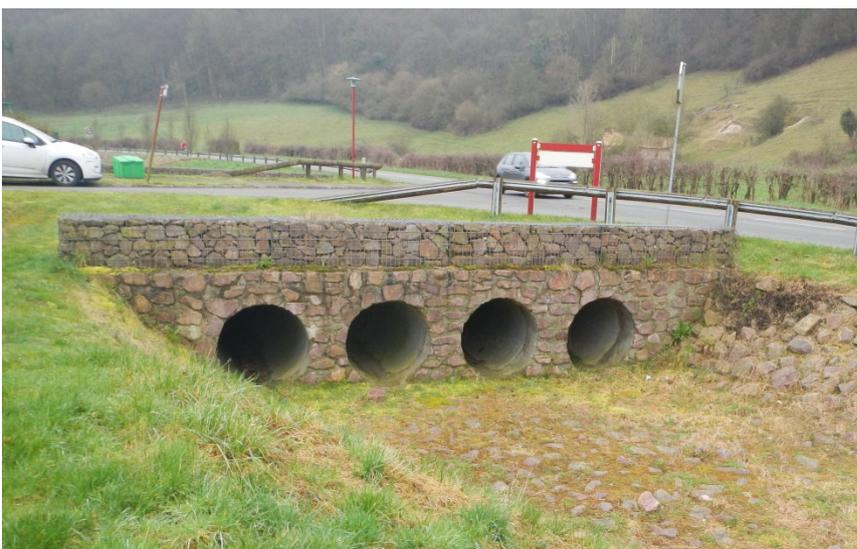
Figure 8: Ouvrages traversiers des secteurs 1 à 3 : 4 buses de diamètres 1 mètre et de longueur 25 m.
